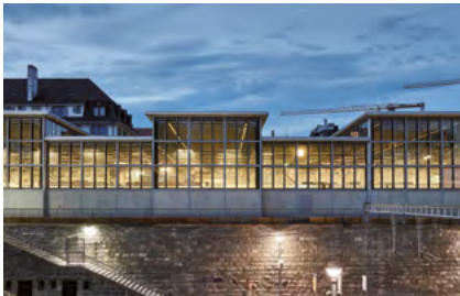
11 Tramdepot Verkehrsbetriebe, Zürich/CH
